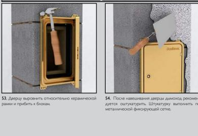
53. Дверцу выровняйте относительно керамической рамы и герметиком. Шпатель выровняйте по металлической фигурной сетке.
