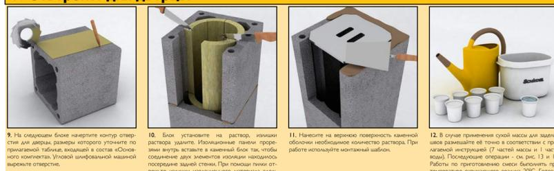
9. На следующем блоке наметьте контур отверстия для дверцы, размеры которого указаны в таблице. Для сухой смеси используйте цементно-песчаный раствор марки М150. Выровняйте по строительному уровню.
