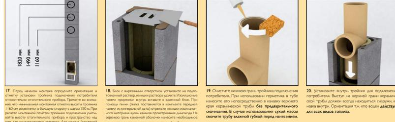
18. Блок с вырезанным отверстием установите на подготовленный раствор. Используйте монтажный шаблон. При вырезании блока используйте монтажный шаблон. При вырезании блока используйте монтажный шаблон. При вырезании блока используйте монтажный шаблон.
